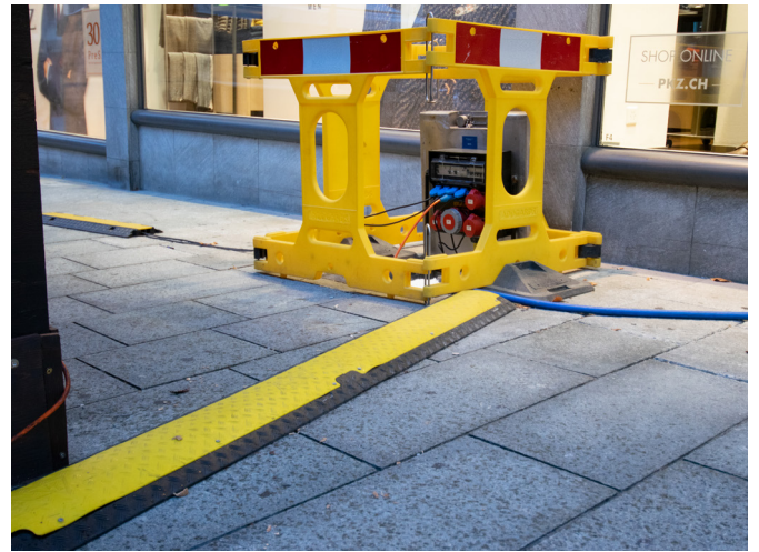
Pont de câble SMART
